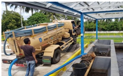
Pengelolaan Lumpur Tinja di IPLT Kota Payakumbuh yang dikelola Dinas Perumahan Rakyat dan Kawasan Permukiman
