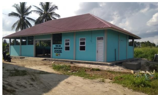
Pembangunan TPS3R Bantuan BPPW Sumatera Barat Kementerian PUPR
